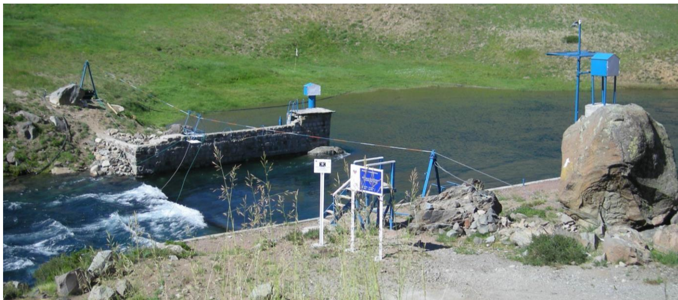
Estación DGA “Río Maule en Desagüe Laguna del Maule”
