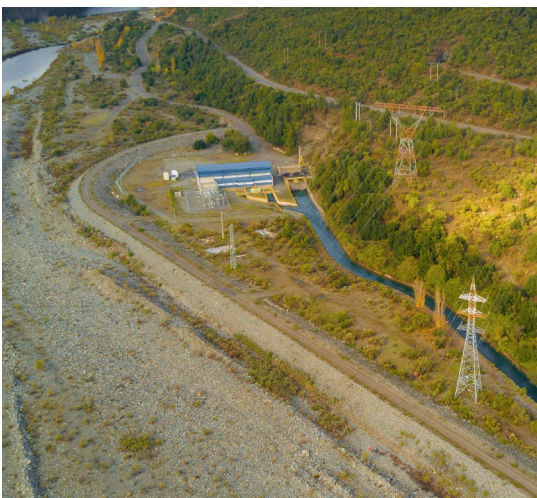
Central Chiburgo y Canal Matriz Maule Sur
